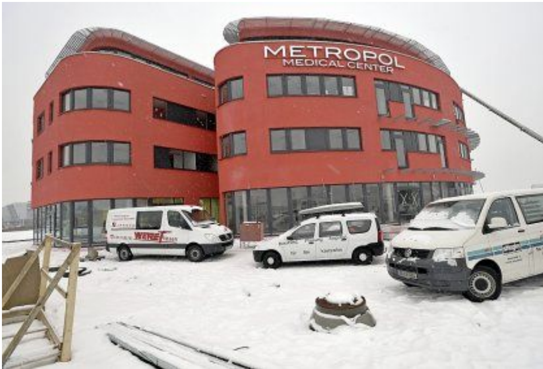
Fast fertig: Zehn Millionen Euro werden in das neue »Metropol Medical Center« in der Virnsberger Straße in Nürnberg investiert. Im Januar wird das Medizinerzentrum eröffnet. Fotos: Harald Sippel
